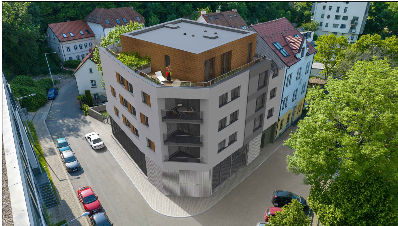
Jihovýchodní nadhled - hlavní průčelí
